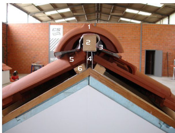
Fig. 5 - Montagem "a seco" da cumeeira.
