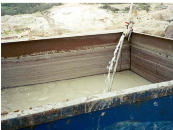
Figura 22. Composição de calda de cimento, água e bentonite (esquerda) e esquema representativo do campo de aplicação das diferentes composições de caldas (direita)
