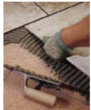
Fig. 3 – Assentamento de ladrilhos cerâmicos de monoczedura sobremármore pré-existente.
