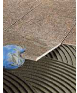
Fig. 1 – Assentamento de pavimento em mármore pré-polido
