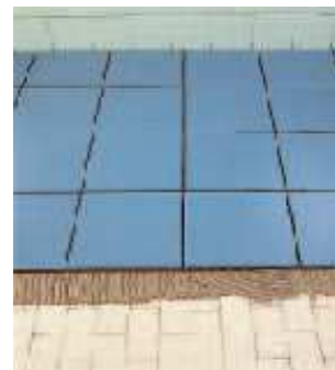
Fig.s 4,5 e 6 – Assentamento de cerâmica sobre pavimento cerâmico pré-existente com Keraflex cinza.
