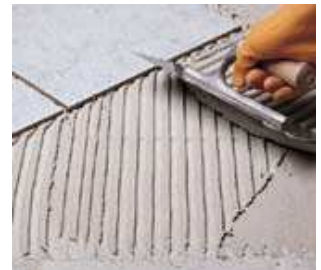
Fig. 2 – Assentamento de ladrilhos cerâmicos de monoczedura sobre parede de blocos de cimento alveolar.
